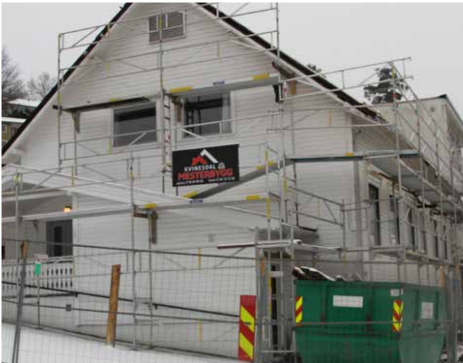
Bildet over: Slik så tidligere Liknes bedehus ut i vinter.
